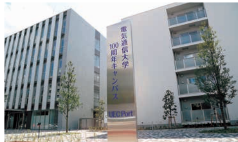
小島町地区に完工した100周年キャンパス「UEC Port」は、学生宿舍、共同研究施設等から構成。本学の発展と地域・社会との連携・共生に役立つ場です。
