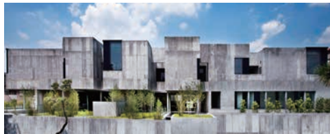
日建設計の山梨知彦氏による調布キャンパス1号館は2014年に完成。遮音を考えて配置されたガラス張りの教室に広い廊下を巡って光が入りこむ。日本建築業連合会「第56回BCS賞」受賞。
