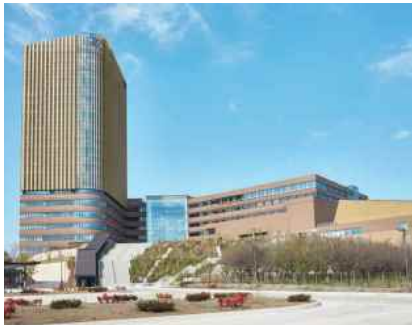
八王子キャンパス新校舎棟「SORATIO SQUARE」。
